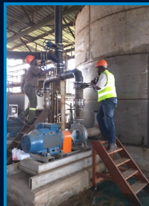
Reconditionnement des valves
